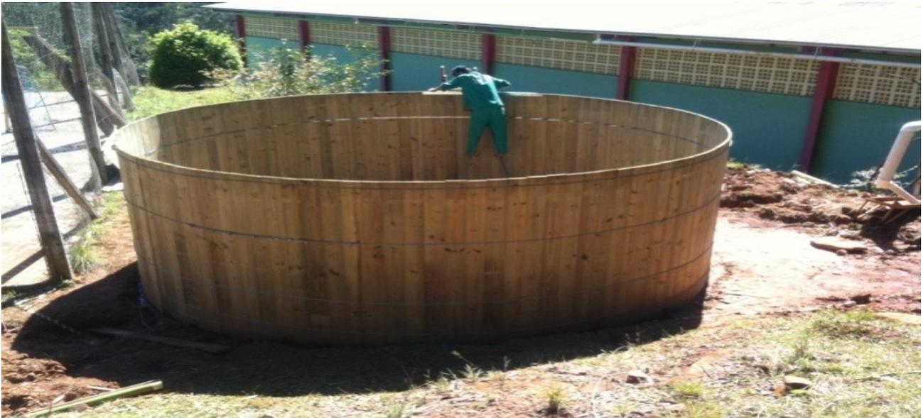
O reservatório interno foi revestido com geocomposto de PVC, ou Geomembrana. Este é um dos tipos mais comuns de geossintéticos e consiste em uma manta de liga plástica, elástica e flexível, pois apresenta excelente desempenho quando utilizada como revestimento impermeabilizante. Salienta-se que esta pode ser aplicada sobre o solo liso, mas isento de elementos perfurantes, graças à sua maleabilidade e flexibilidade.
