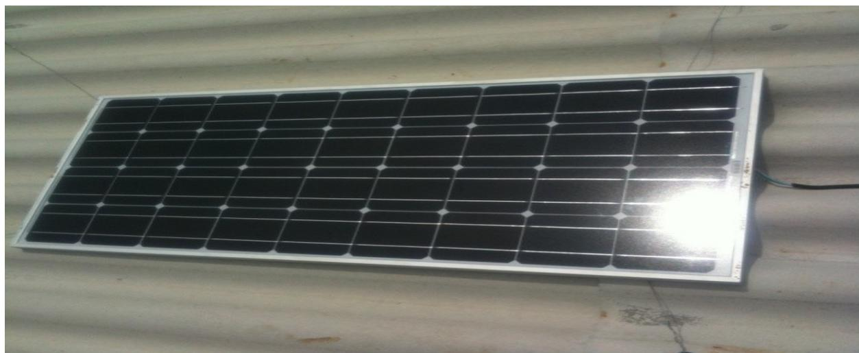
A célula fotovoltaica recebe e capta luz solar e a transforma em energia elétrica. Esta transformação é responsável por acionar a bomba instalada ao lado da caixa de 500 litros, próximo ao reservatório de água. Esta caixa é abastecida pelo próprio reservatório com água não potável. Quando o reservatório não tiver água suficiente à caixa é abastecida por água tratada.
