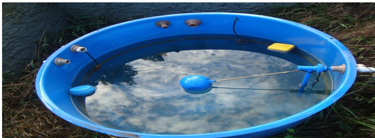
A Caixa d'água de 500 litros cheia com água do reservatório de madeira. A boia senóide cor amarela é responsável pelo acionamento da bomba que distribui água no segundo andar da escola. Ainda, libera água tratada da casan quando não tem mais água no reservatório de captação. Esta água da caixa é distribuída para todos os 27 (vinte sete) vasos sanitários da escola.
