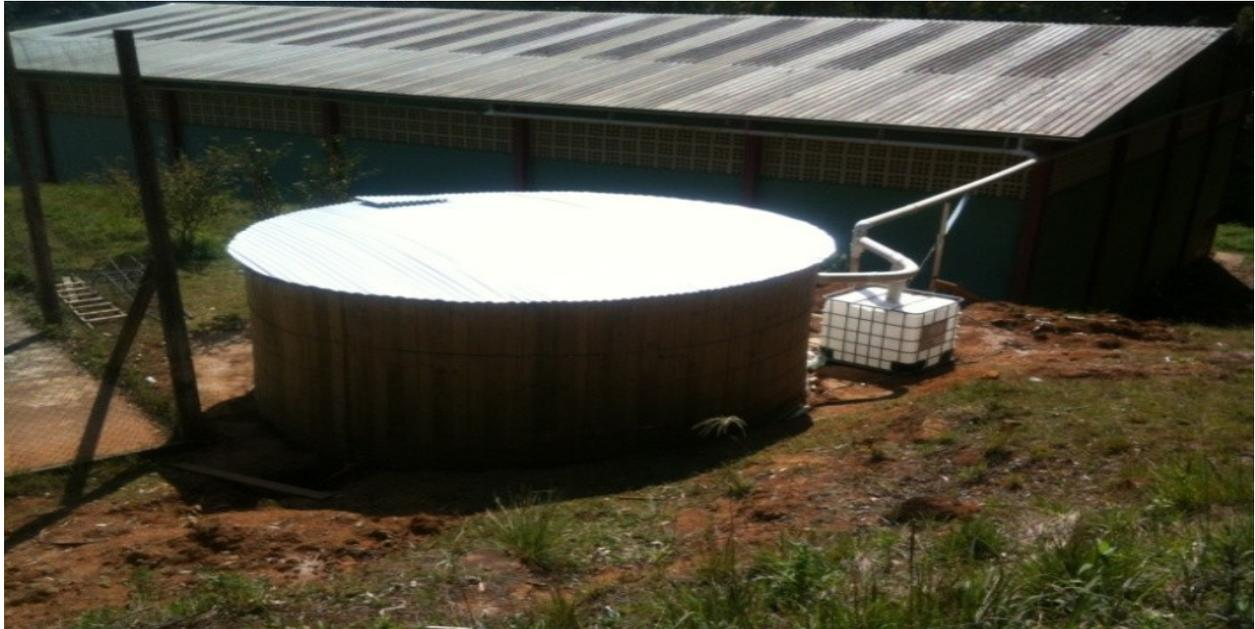
No entorno do ginásio foram instaladas calhas nas quais a água da chuva coletada será transportada por canos de PVC 100 e 150 mm até o reservatório.
